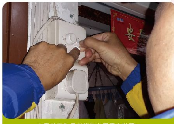
中電義工為長者維修家居電力裝置，並貼上指示，方便長者使用。
