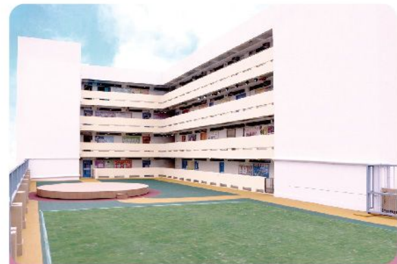
四樓平台發展為「欣茵平台」，一片青草地乃全港首間中學採用高端科技建設低碳、淨化空氣、調降溫度草被，讓學生進行多元學習活動及科學探究
